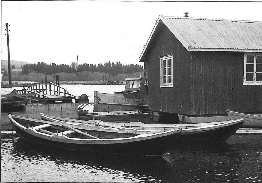
Fløtningsbåter fra Fetsund lense, mens fløtningen fortsatt var i drift. Båtene er uvanlige i norsk sammenheng, glattbygget på jernspant. Foto A.E. Chr.
